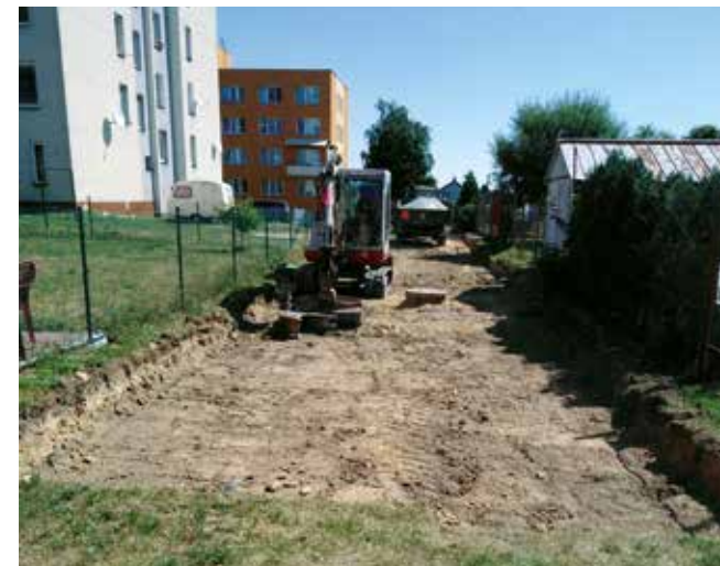
Aby byla oprava místních komunikací prostřednictvím recyklátu účinná, musí se provádět v letních měsících, kdy se asfalt teplem spojí a zpevní tak opravovanou plochu.
